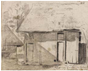
Grange et écurie au Capleneihus à Bernwiller, 1855
